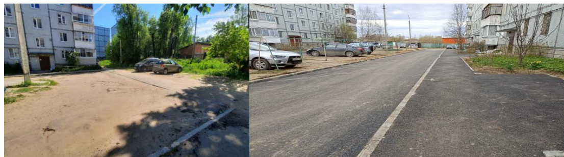
Дворовая территория по ул. Карьерная, д. 14
